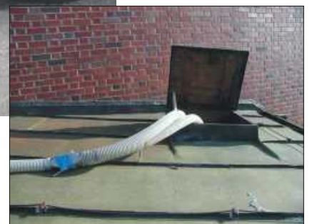
Leichte Montage der fugenlosen Dämmschicht
